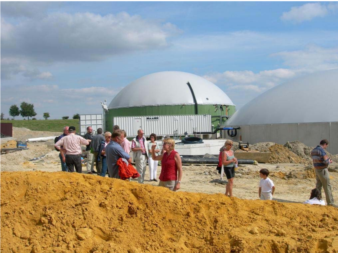
Bioenergiedorf Jühnde in der Bauphase
